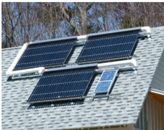
5-rasm. Quyosh fotoelektrik issiqlik qurilmasi.
