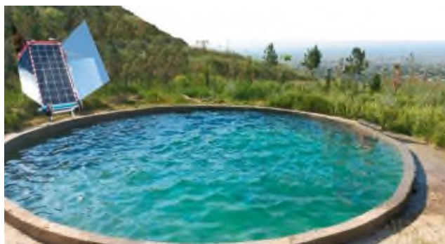
3-rasm. 80 m 3 sig'imli suv havzasi va tomchilatib sug'orish uchun mo'ljallangan fotoelektr tizim.
